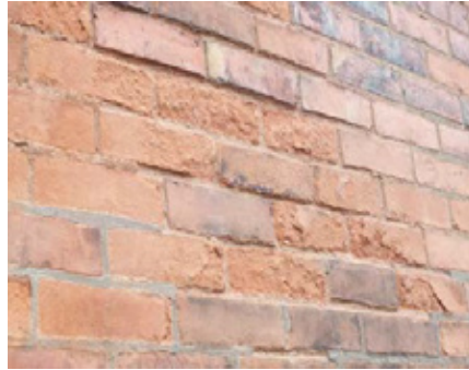
Spalling
